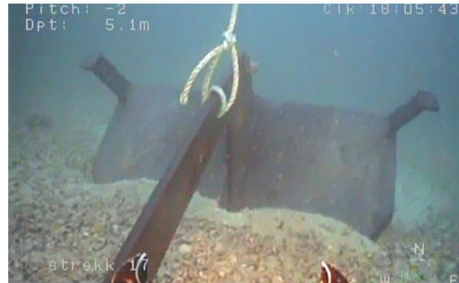
Anker ferdig utsatt uten strekktesting
